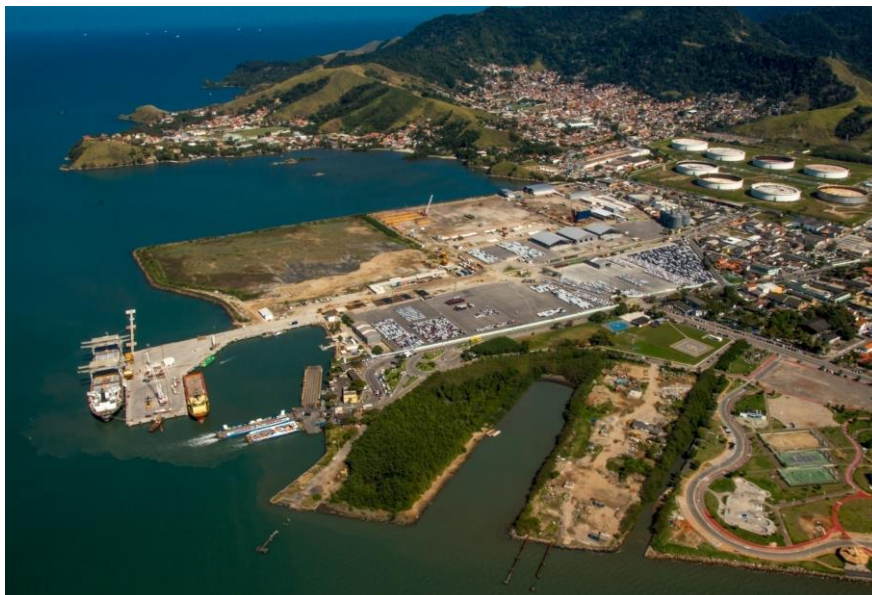
Porto Organizado de São Sebastião – Visão Geral
